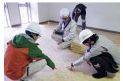
施工管理(サーラ孺恋建設工事)
