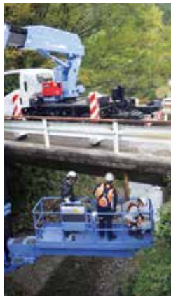
橋梁点検状況
