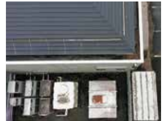
ドローンによる屋根の劣化調査
