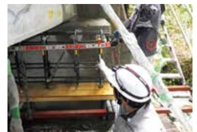
積算・施工管理(橋梁補修工事)
