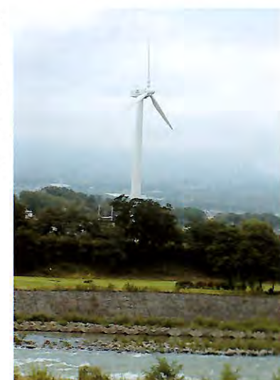
利根川緑地公園内の吉岡風力発電所
