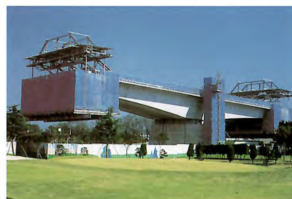
カンチレバー架設(張出し架設)工法で施工中の上毛大橋
