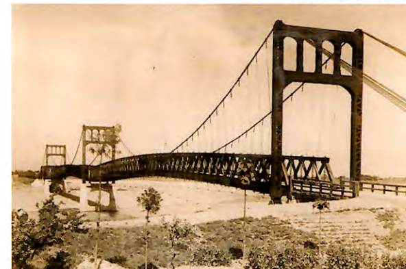
木・鉄混合、吊り橋が併用された昭和28年(1953)頃の五料橋
