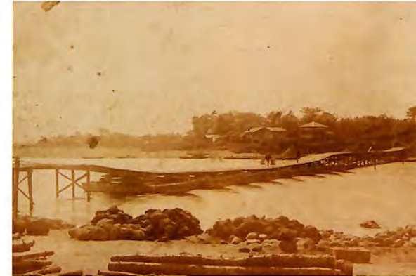
明治40年(1907)、舟8艘による舟橋だった頃の五料橋
