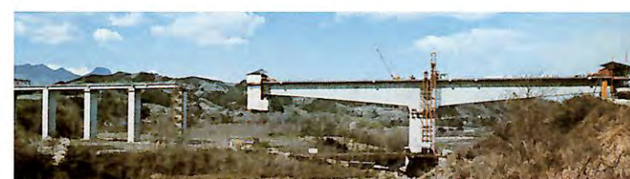
架設中の吾妻川橋梁
