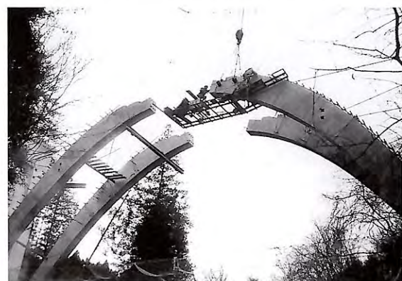
アーチ部の架設工事
