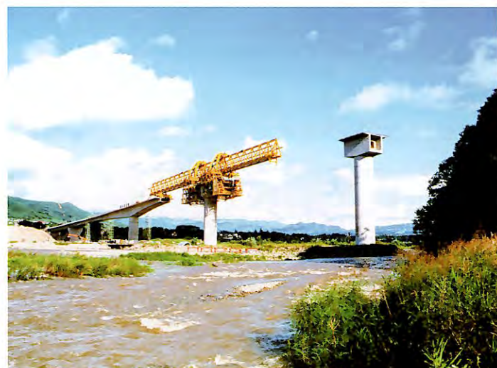
桁下からの作業なしで施工中の月夜野大橋
