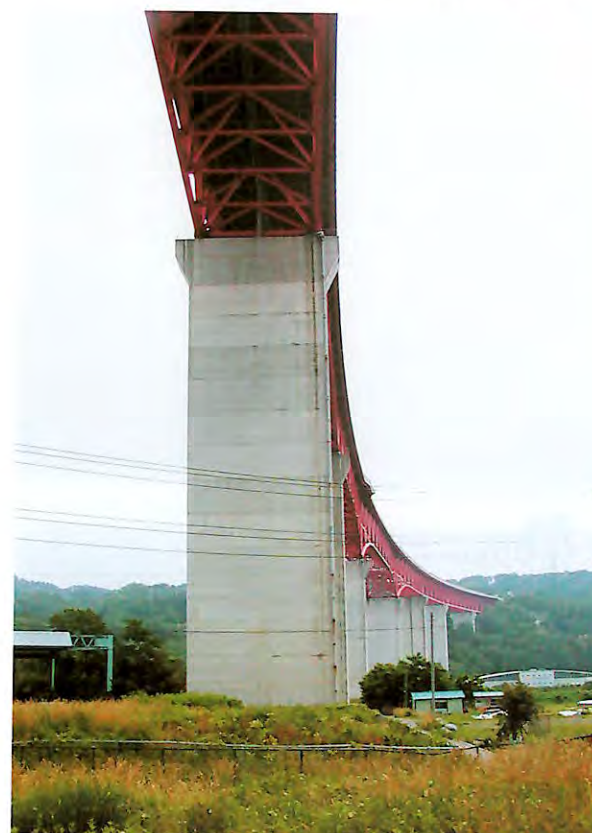
橋下に立つとその雄大なスケールが感じられる
