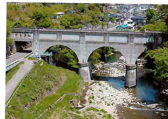
水路橋が黒岩渓谷を跨ぐ
