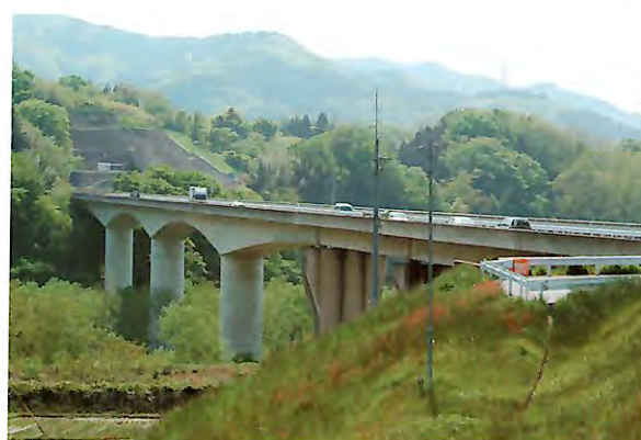
月夜野IC側から見る月夜野大橋
