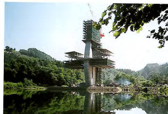
尾瀬大橋施工プロセス1
