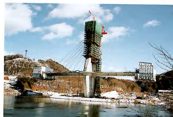
尾瀬大橋施工プロセス2
