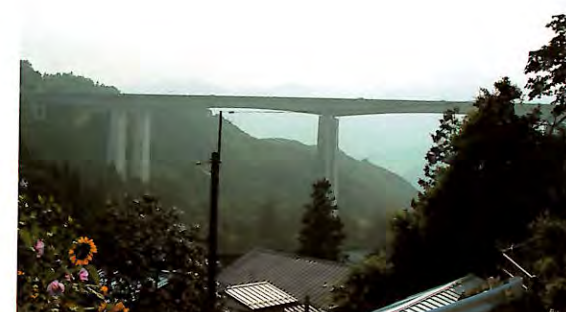
えぐられた谷間を貫く永井橋、遠景
