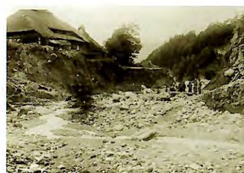
沼尾川支川前入沢被災状況(昭和22年)
