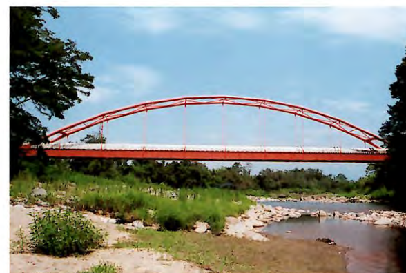
榛名幹線・吾妻川架橋水管橋
