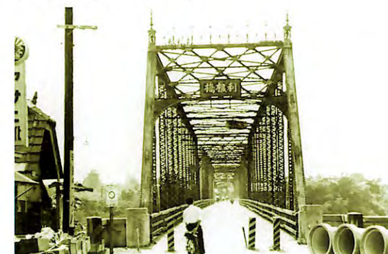
旧利根橋（明治34年（1901）完成）
