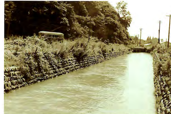
取水口地先（ちんちん電車 前橋駅～渋川駅 昭和20年代）
