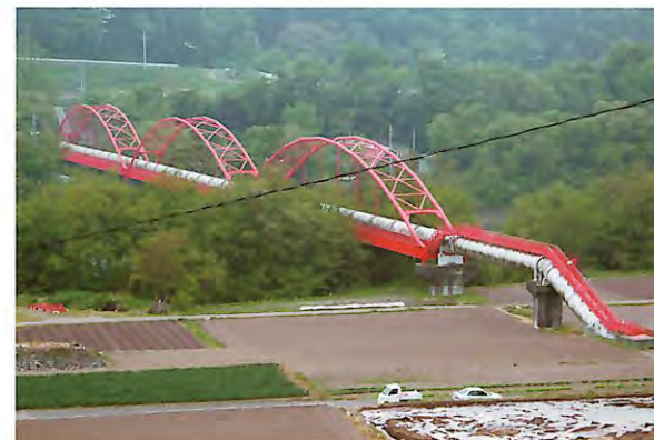
赤城幹線・利根川架橋水管橋
