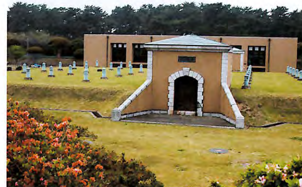
1号浄水池（旧1号、2号浄水池を使用）
