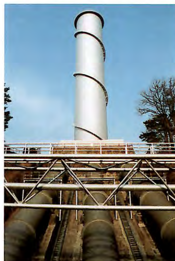
佐久発電所サージタンク
