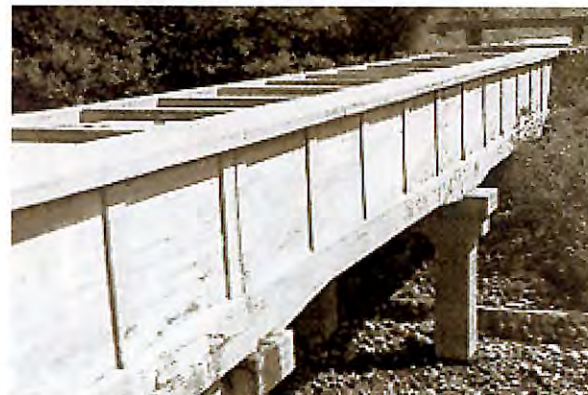
漏水がひどいため改修した初代の細ヶ沢水路橋（昭和28年（1953））
