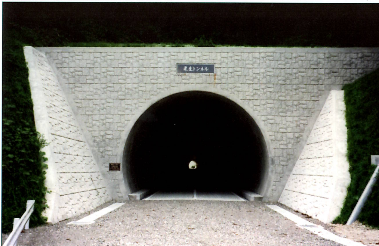
◆◆新トンネル(栗生トンネル)
