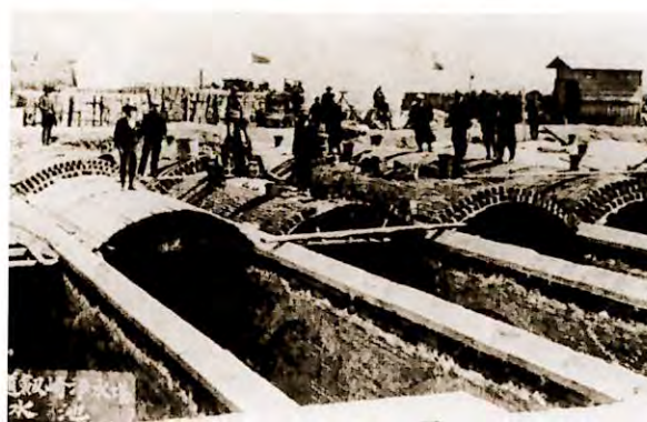
創設時剣崎浄水場配水池築造工事
