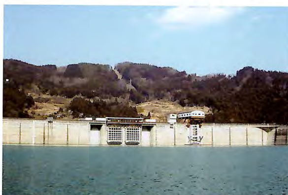
下久保ダムの取水施設
