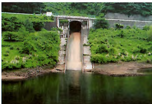
相沢導水トンネル放流口
