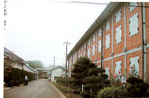
和洋折衷方式の木骨レンガ造倉庫
