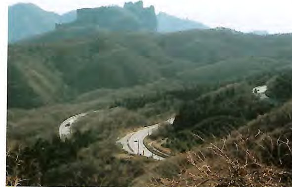
入山峠から見る急峻な国道18号
