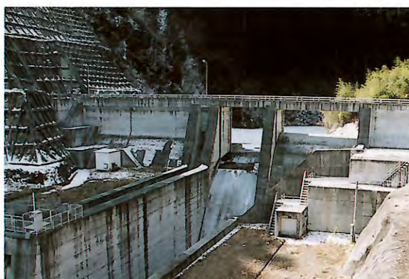
市野萱取水ダム
