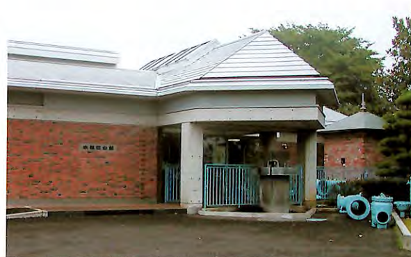
水道記念館。玄関右脇は創設当初のベンチュリーメーター室
