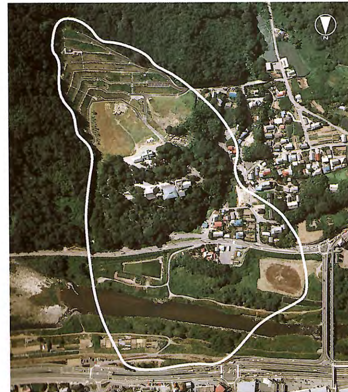
第4期対策施工後の寺沢地区ブロック
