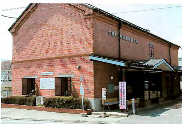
大正時代の倉庫を改築した甘楽町歴史民俗資料館
