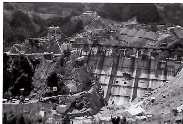
施工中の下久保ダム(昭和42年(1967))
