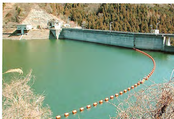
湖側から堤体を見る
