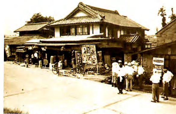
昭和35年6月/藤塚地区地すべり末端部旧国道18号<隆起前>
