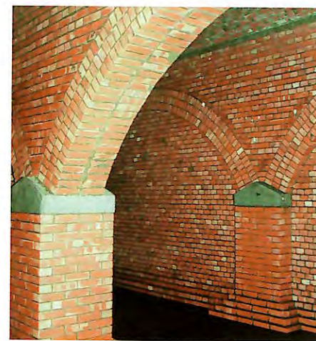
当時の剣崎浄水場配水池内部
