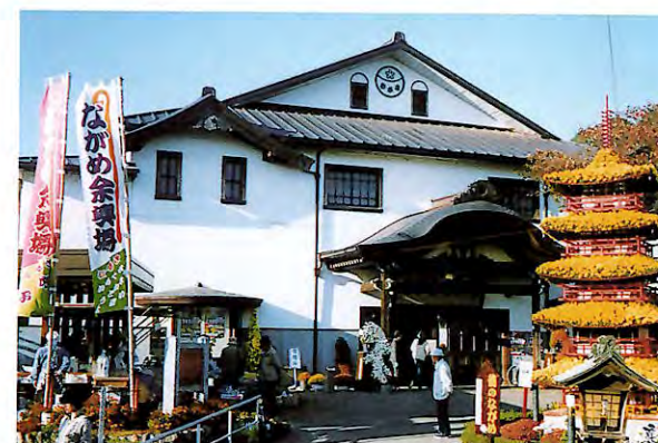
ながめ公園内の木造劇場・ながめ余興場
