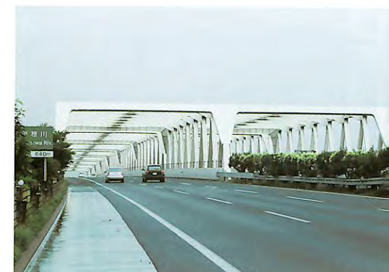
利根川橋（館林側）
