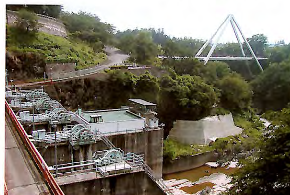
高津戸ダム(発電所)とはねたき橋
