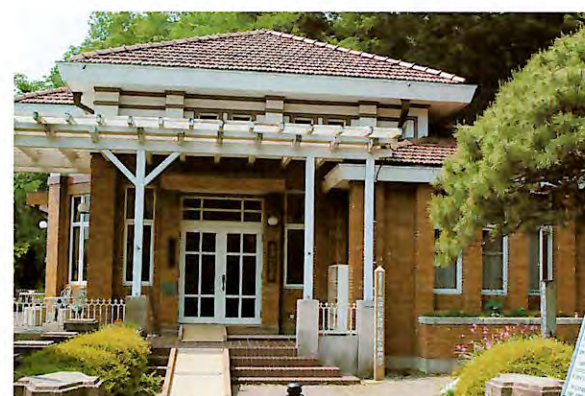
桐生市水道山記念館（旧配水場事務所）
