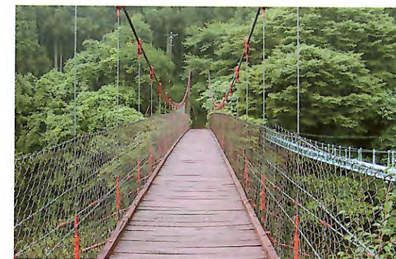
下松島橋は小中駅に通じる生活橋である
