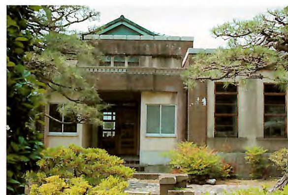
元宿浄水場（水道資料館）
