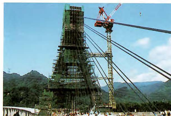
大容量ケーブルを用いた張り出し架設
