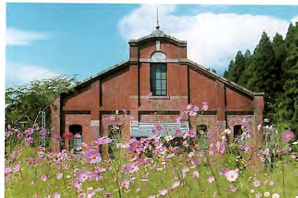
在りし日を伝えるアプト式軌道の心臓部、丸山変電所
