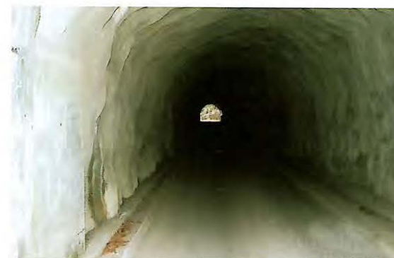
ゴツゴツとした壁面が手掘りトンネルの苦勞を偲ぼせる
