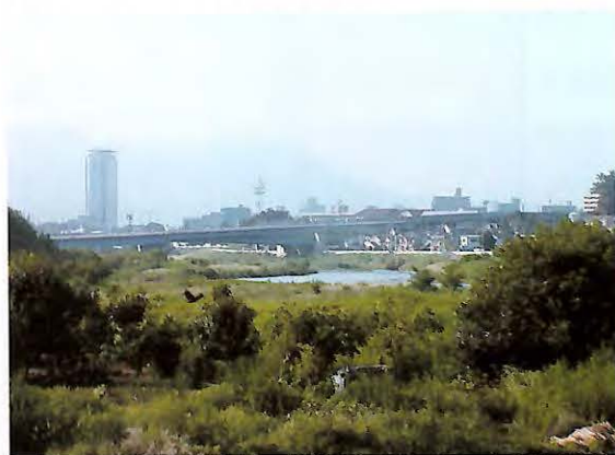
3階建ての立体構造を持つ城南大橋
