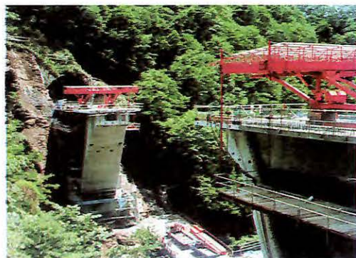
片持架設工法による施工
