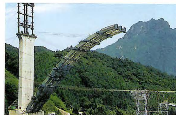
斜吊架設工法によりアーチリブを架設
