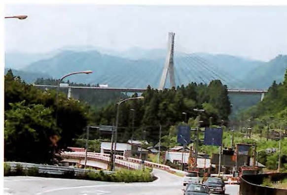
国道18号から見る碓氷橋
