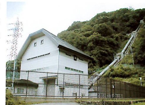
鹿沢発電所（旧田代発電所）
