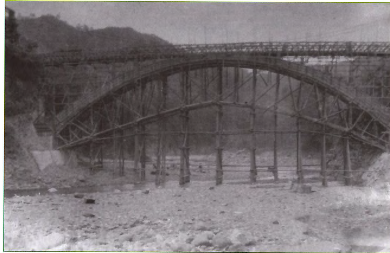
◆◆施工中の写真
