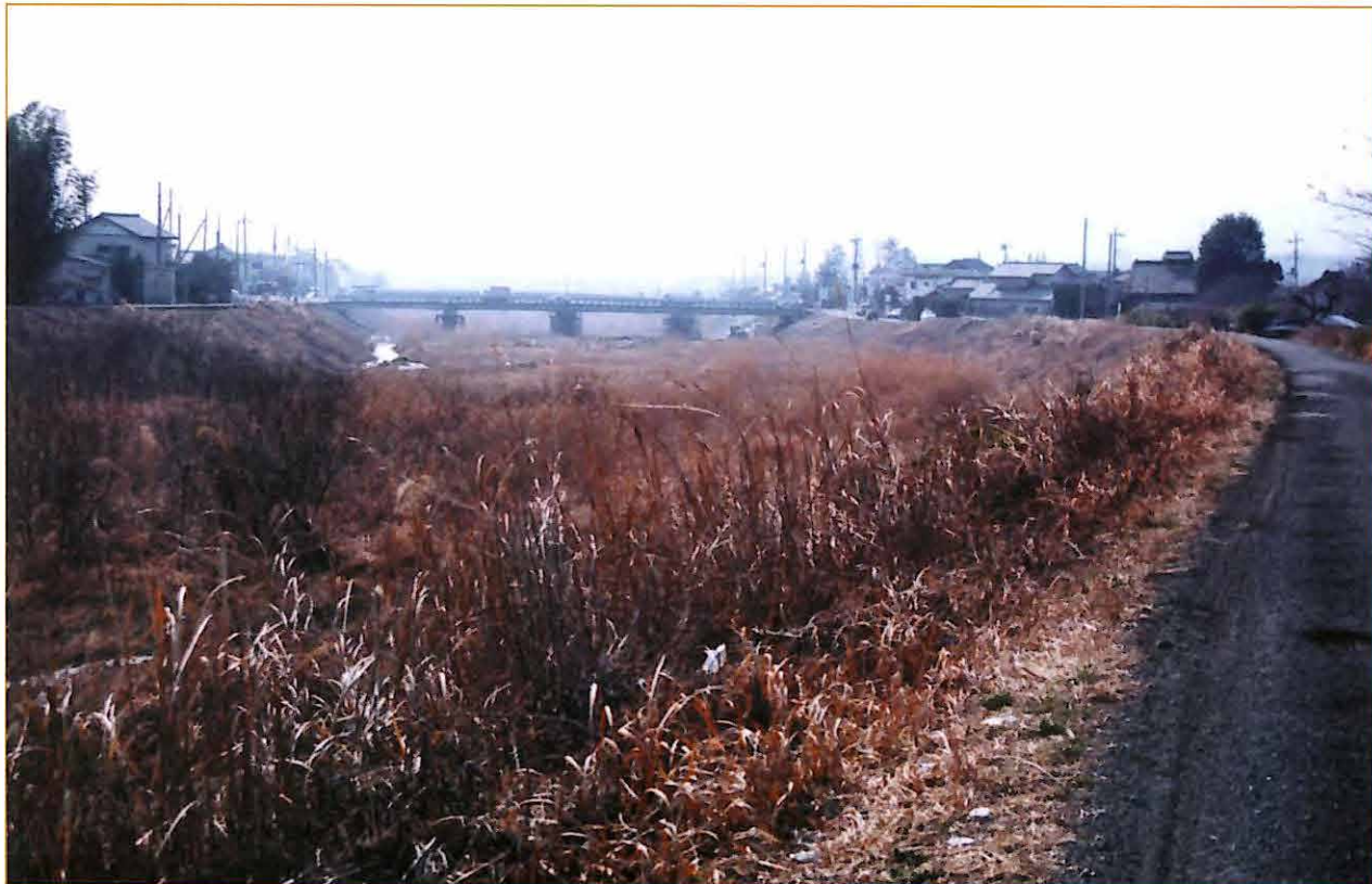
◆◆河川断面(上流部)
