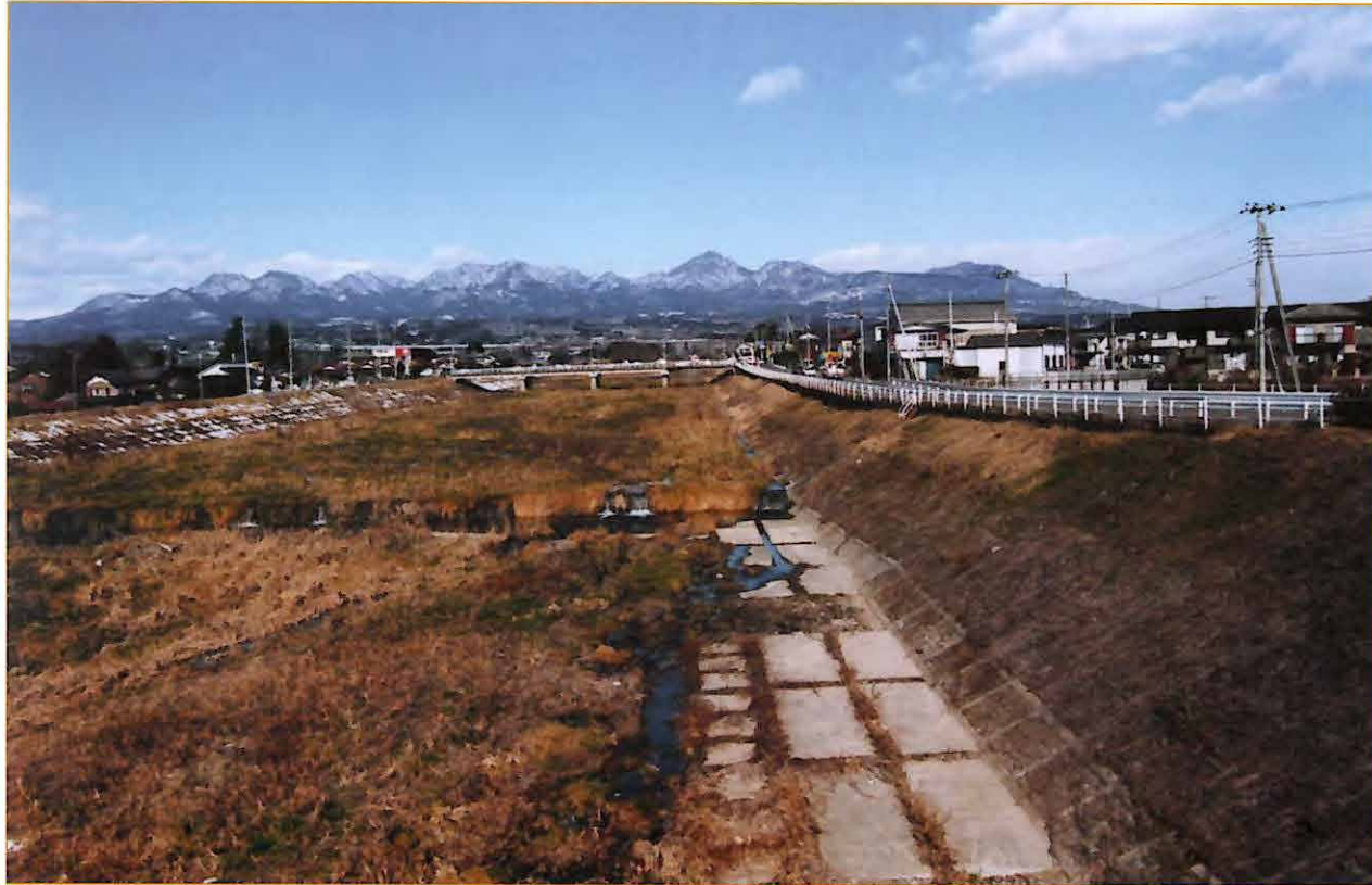
◆◆河川断面(下流部)
