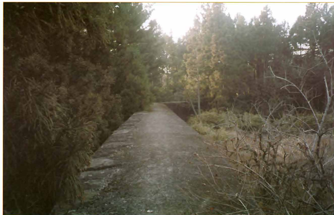
◆◆折線形の堰堤天端
