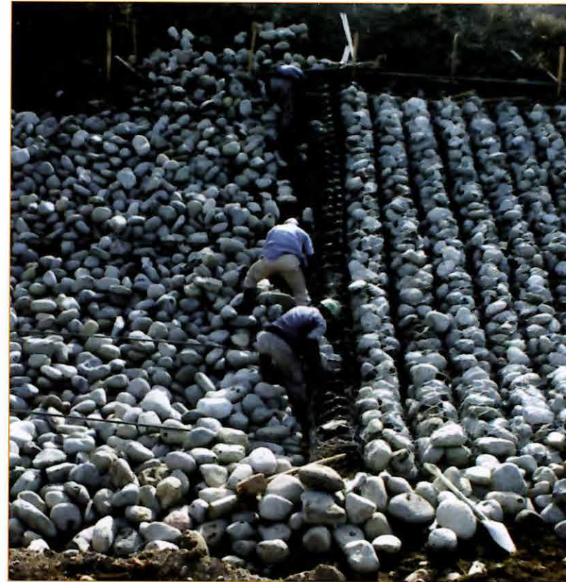
◆◆ 鉄線蛇籠の施工状況
