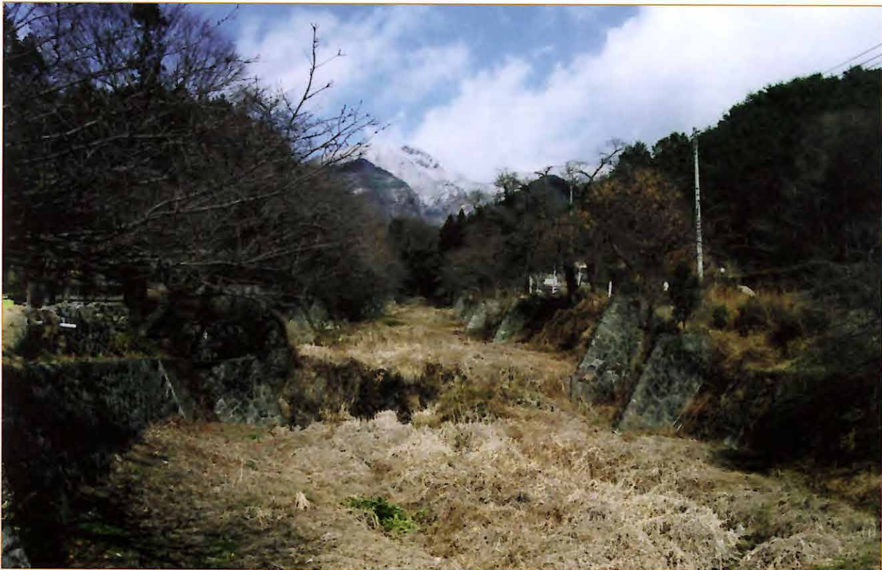
◆◆ 全景(下流から)
