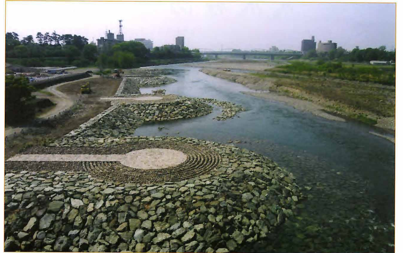
◆◆下流側(ふるさとの川モデル事業 施工後)
