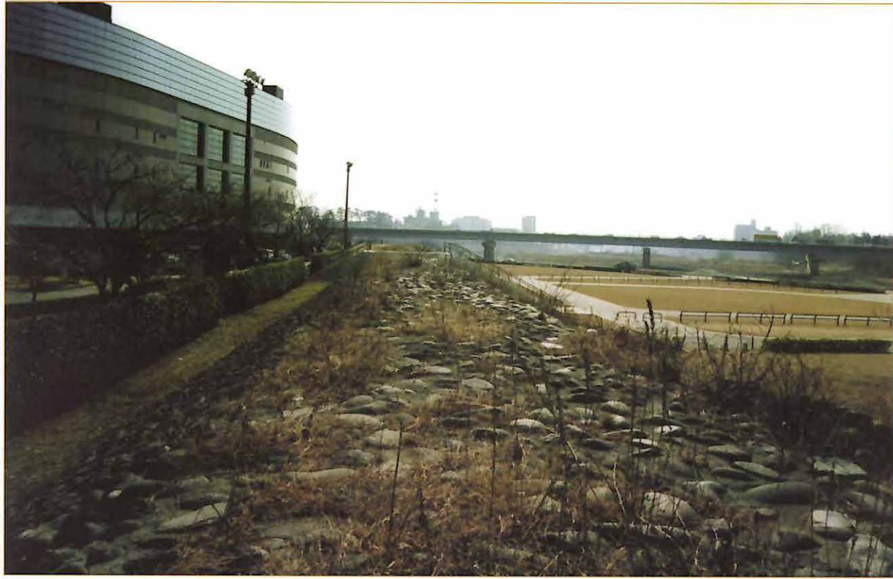
◆◆グリーンドーム上流部
