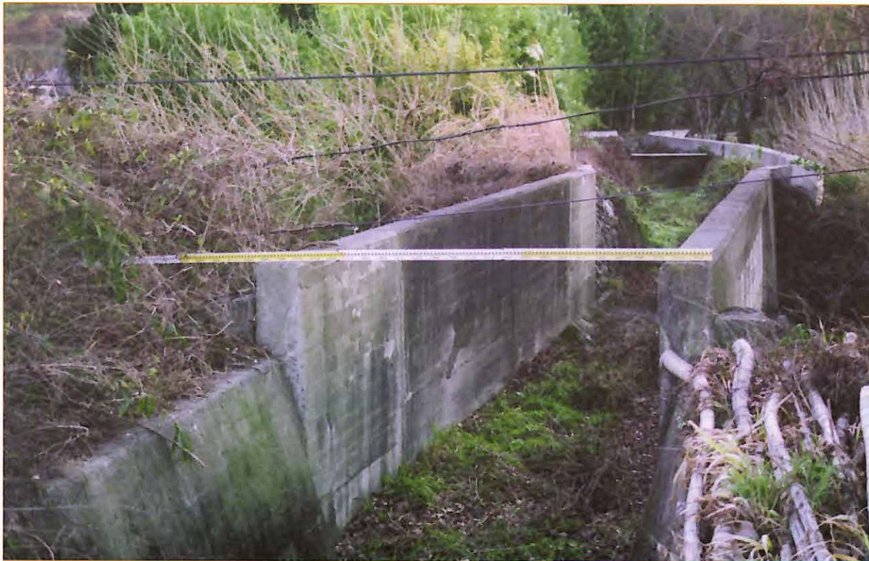
◆◆水路橋上下流
