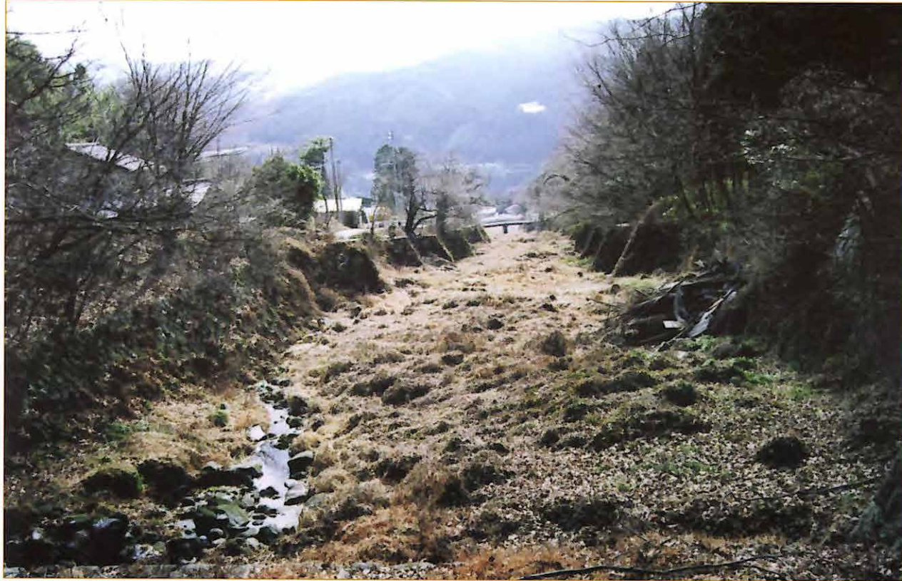
◆◆ 全景(上流から)
