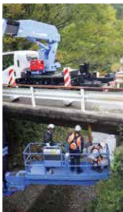
橋梁点検状況
