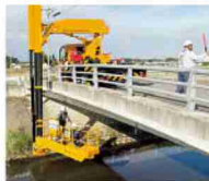
橋梁点検状況
