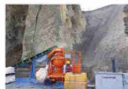
積算・施工管理（法面吹付工事）
