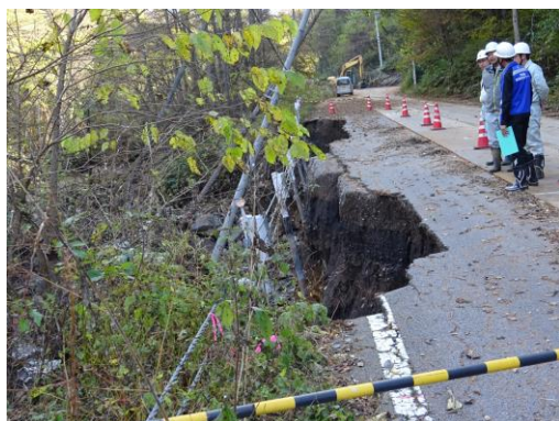
道路災害状況
