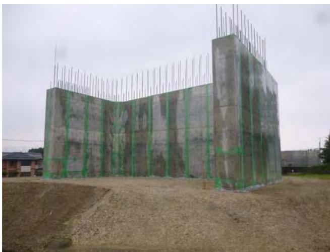
脱枠後、前面に農業用ビニールシートで躯体を覆い、乾燥収縮を防止した。
