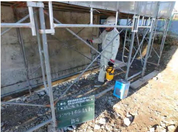
脱型直後のコンクリートに塗布することにより、コンクリート表面に浸透し、水分の蒸発を抑制するとともに、空隙中の自由水の表面張力を下げ、乾燥収縮を低減する。
