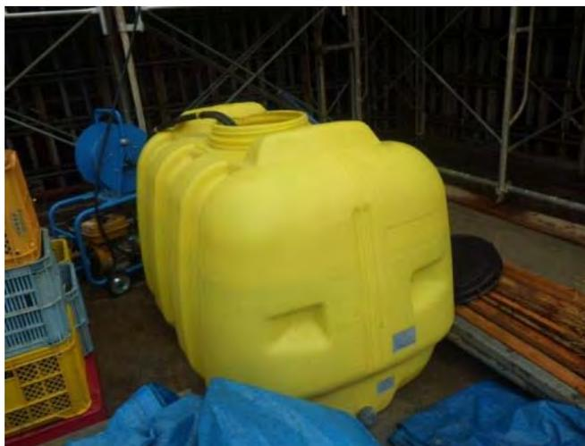
養生水は1日現場に置いたものを使用し、コンクリート表面の急激な温度変化を防止した。
