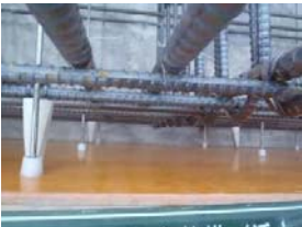
かぶり内の 結束線確認
