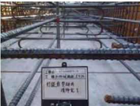
型枠内の 清掃状況
