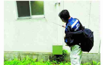
外壁調査状況
