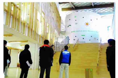
完成検査(みどり市立笠懸西小学校新築工事)
