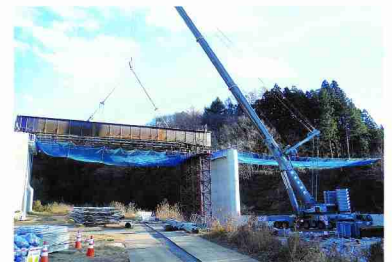
積算・施工管理(武尊大橋上部工事)
