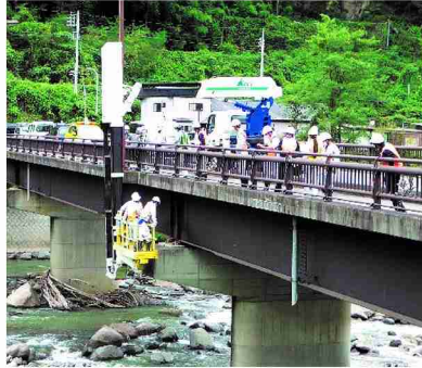
橋梁点検状況
