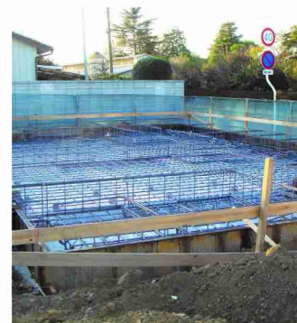
住宅瑕疵担保保険に係る基礎配筋検査
