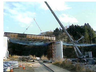
積算・施工管理((仮称)姥堂大橋上部工工事)
