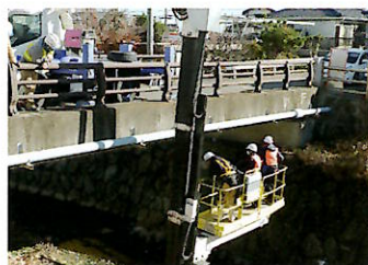
橋梁点検の状況
