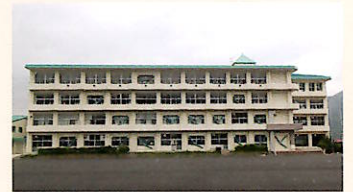
発注者支援（吾妻広域消防本部）
