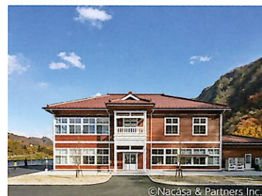
施工管理(長野原町横壁地域振興施設)
