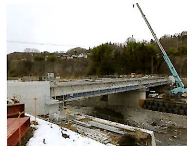
積算・施工管理(大前橋上部工工事)
