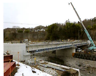
積算・施工管理(大前橋上部工工事)
