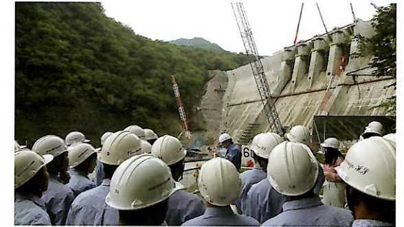
現場見学会(ハツ場ダム)
