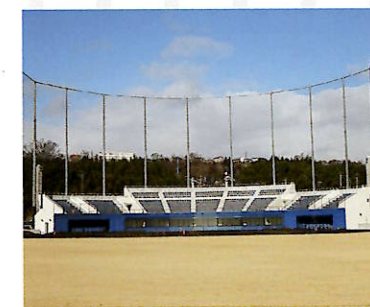
施工管理(沼田市利南運動広場整備工工事)
